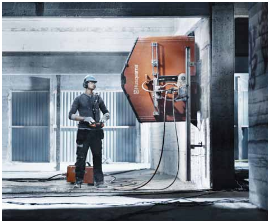
Väggsågen har försetts med nytt klingskydd av aluminium.
