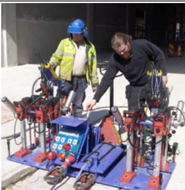
Ny tågterminal i Södertälje. Fyra samtrimmade Joker Quick, åtta parallella Hilti bormaskiner och 17.000 hål.
