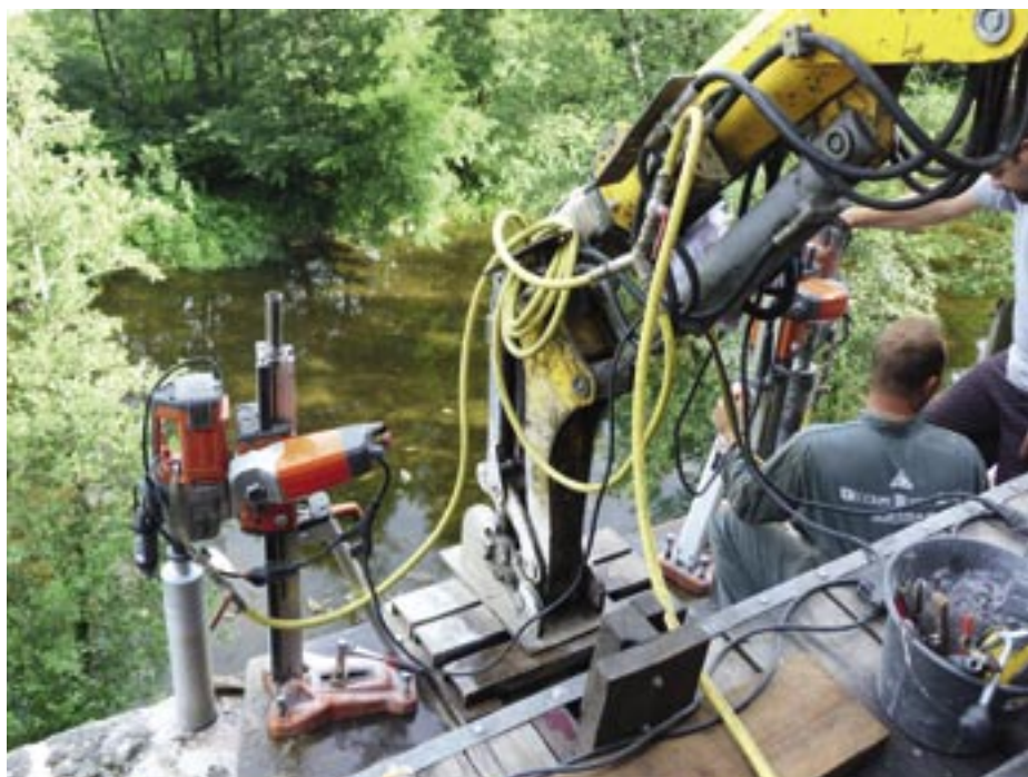
När den gamla ångjärnvägen i Frankrike renoveras ska fler än 7000 hål borrar för att få ett skyddsräcke på plats.
