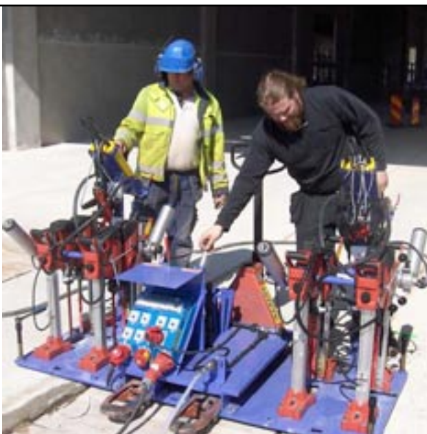
Ny tågterminal i Södertälje. Fyra samtrimmade Joker Quick, åtta parallella Hilti bormaskiner och 17.000 hål.
