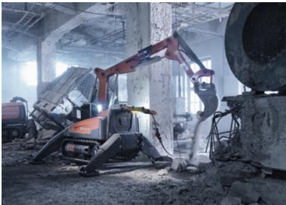
Armsystemet kan roteras helt obegränsat vilket är användbart i trånga utrymme.
