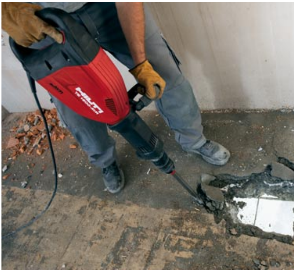
Bilningshammaren väger 14,2 kg och har en effekt på 1800 watt.
