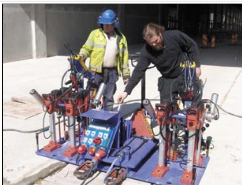
Ny SL-terminal i Södertälje. Fyra samtrimmade Jokrar och 17.000 hål.
