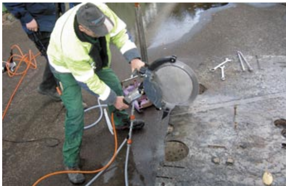
Motorenheten Beluga utrustad med ringsågstillbehöret Kogia.
