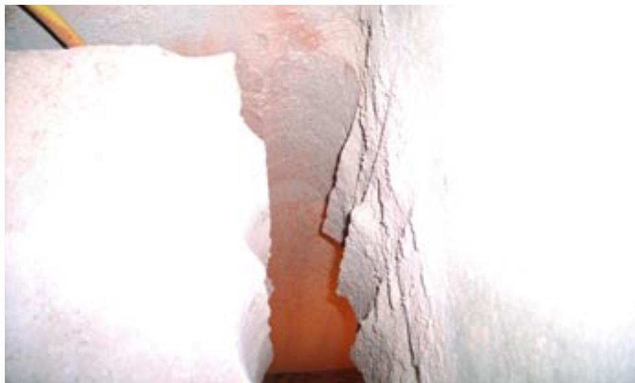
Dækket gennembøres langs væggen.
