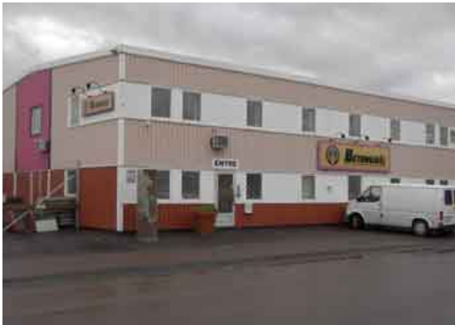
Kontor, verkstad och förråd är centralt beläget på Danmarksgratan i Uppsala.
