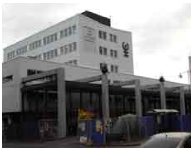
H-Centrum i Uppsala har pågått i två år och beräknas vara färdigt under våren 2007.
