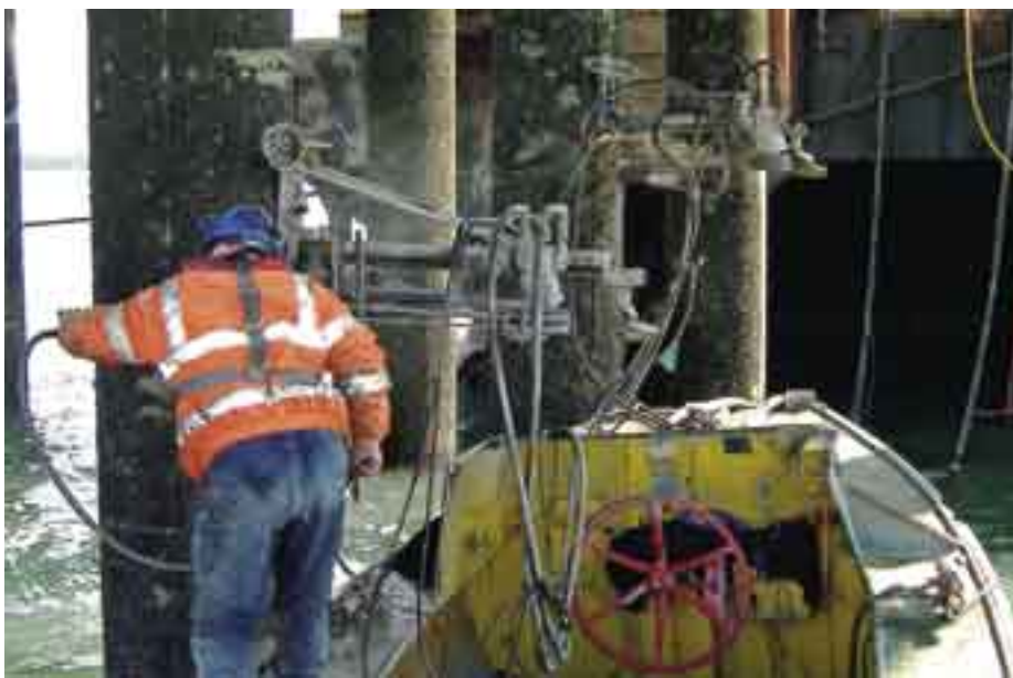
Operatörer från den engelska håltagaren "Drill Cut" använde båtar för att komma åt att vajersåga de 450 betongpålarna.
