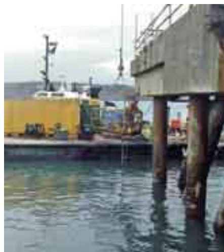
En förankringspåle lyfts bort efter att stödpe-larna under den sågats bort med vajersågar.
