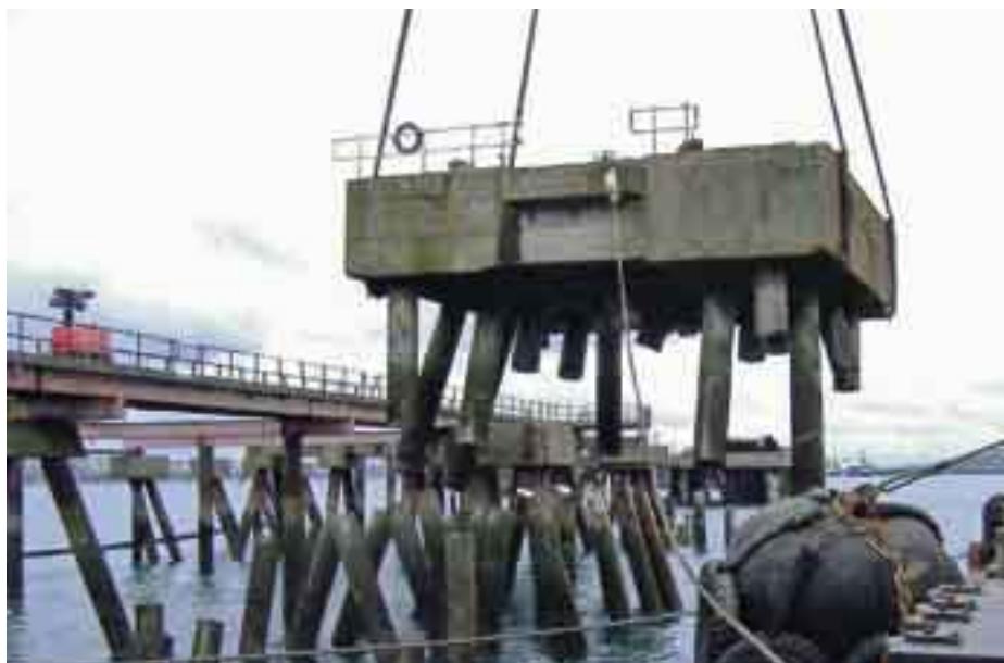
En förankringspåle lyfts bort efter att stödpe-larna under den sågats bort med vajersågar.
