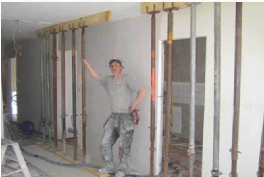
Provisorisk avvaxling inför håltagningsarbete då lägenhet skall öppnas upp vid ombyggnation. Foto: Leif Sjögren
