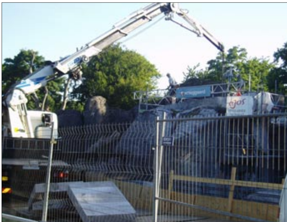
Betonklodser hejses ud fra grotten.
