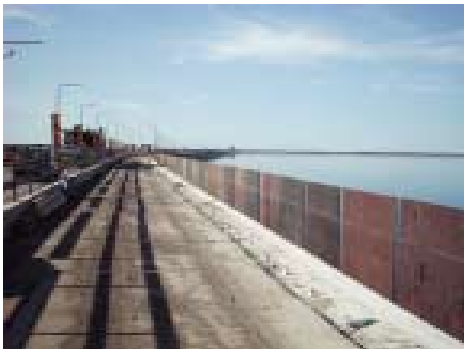
Här ser vi att kantbalken är färdigsågad och väntar på att bli vattenbilad.
