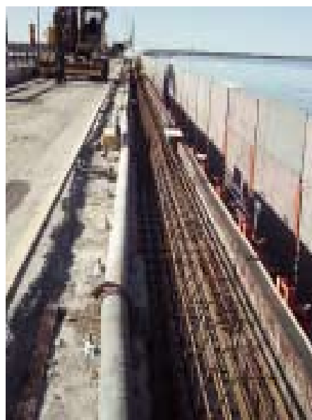
Längst bort ser vi vattenbilning som är i full gång och närmst ser vi hur duktig armeringskillarna varit.
