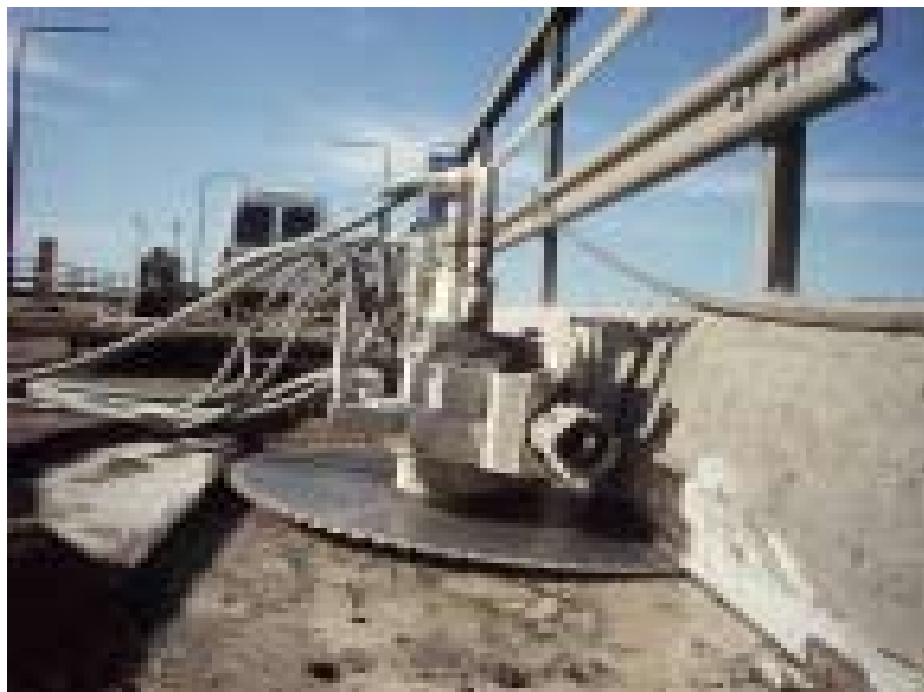
Närbild på sågning av kantbalk på Ölandsbron norra sida.
