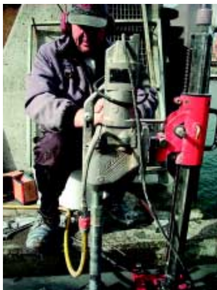
T.v: Borrning med det långa borret som var 1 meter långt.
