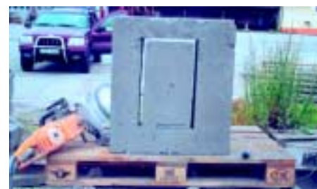
Sågningen är i stort sett färdig!
