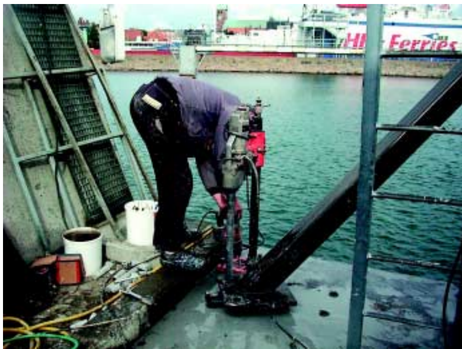
Här ser vi när Bernt Tångvik använder slagbormmaskinen för att göra hål till pinnexpandern som skall spänna fast maskinen mot underlaget.
