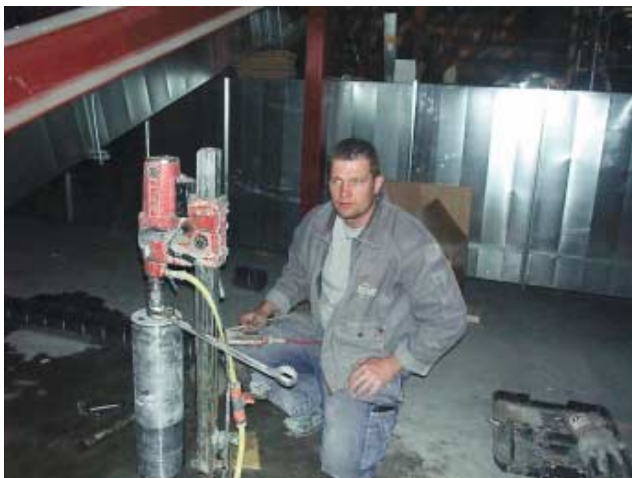
Foto: Patrik Sjögren Asko Karsikko borrar under läktaren.
