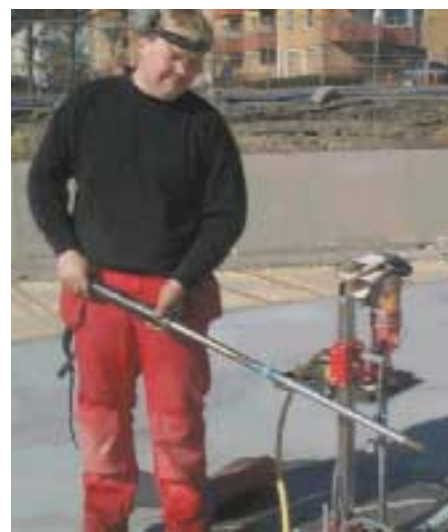
Bilden visar när Martin kastar ut en borkärna, enkelt och smärtfritt.
