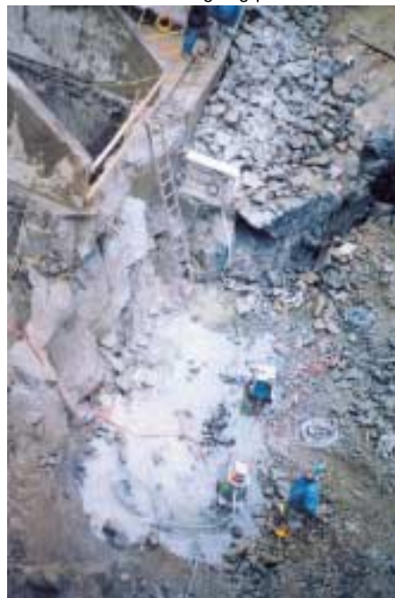
Wiresågning på Nacka strand.
