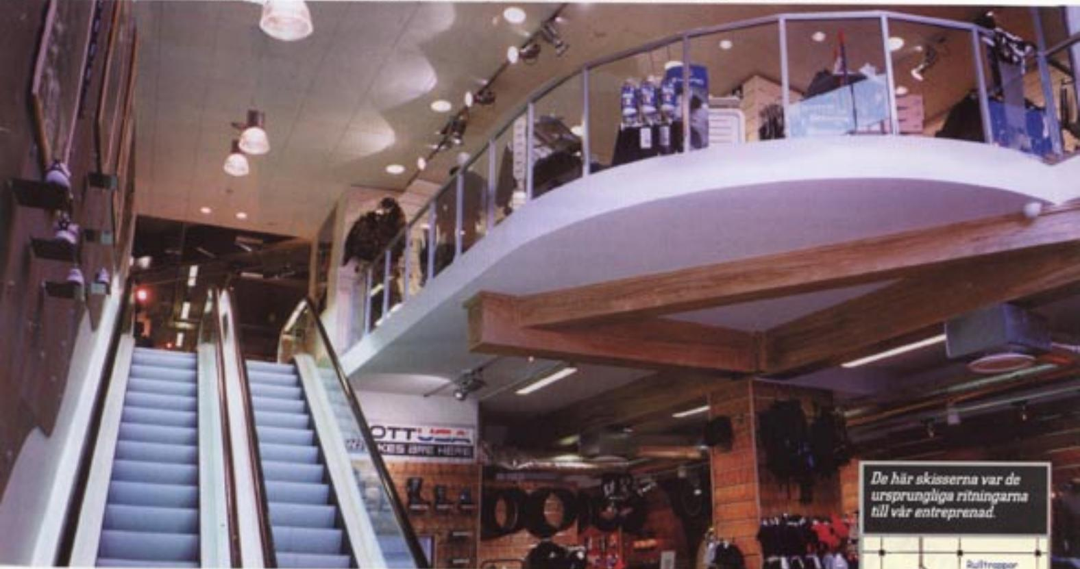
Från Intersport. Den färdiga öppningen med rulltrapporna monterade. Lägg märke till rundingen och det krafiga snidet.
