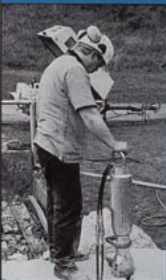
Dardas hydrauliska sten- och betongspräckare övertygar vid spräckning av betong, armerad betong och sten. Den klyvande kraften, upp till 413 ton, delar materialet exakt från insidan utan vibrationer.
