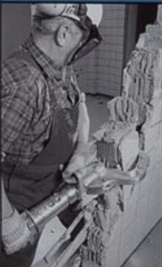
Dardas kombinationsstång HCS 5 gör allt demoleringsarbete lättare. Likt en käft bryter HCS 5 igenom murverk utan damm eller oljud. Käftarnas saxfunktion klipper armeringsjärn, metall och ett otal andra material.
